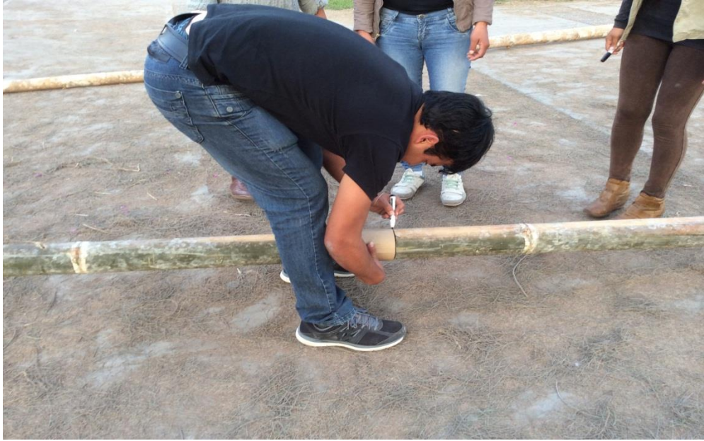
Trazo para el corte perpendicular del bambú
