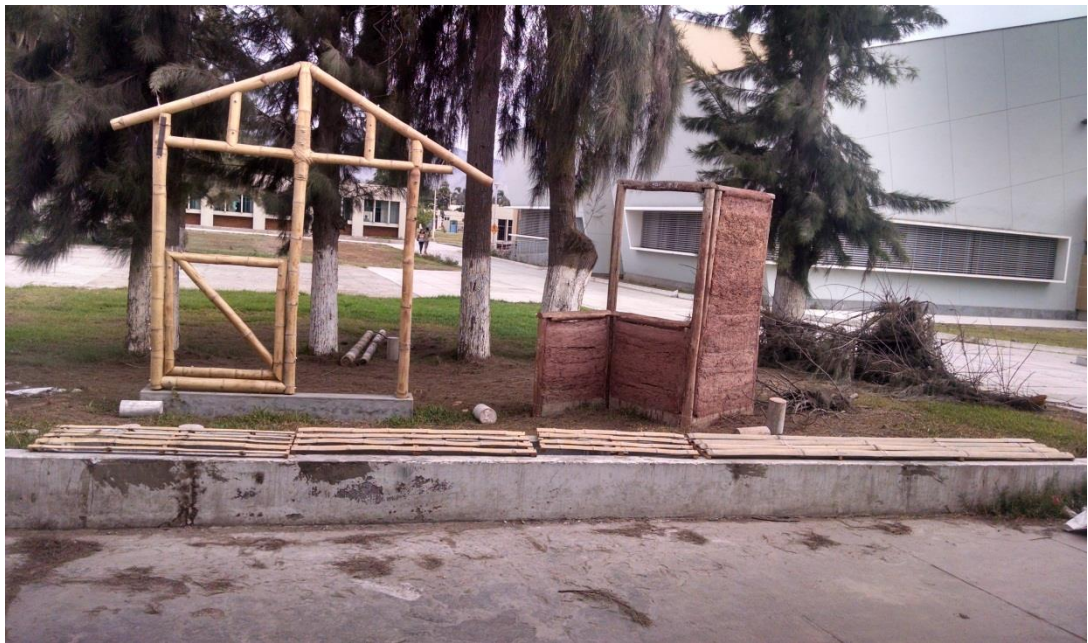
Pórtico apanelado con bambú Guadua Angustifolia
