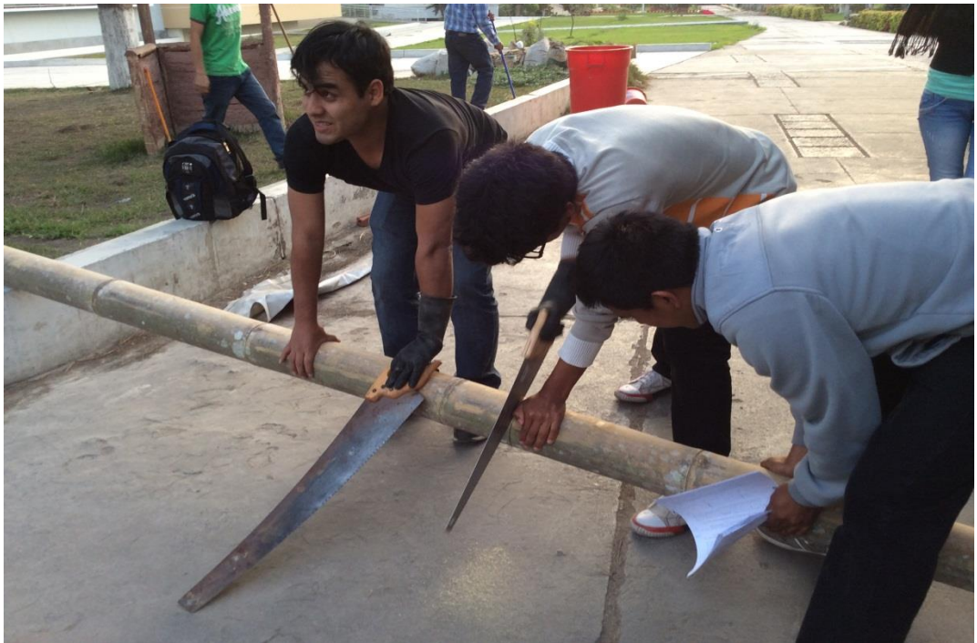
Corte perpendicular del bambú
