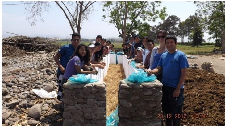
Foto 8. Instalación del soporte del biodigestor tubular de PVC en el IRD - Costa
