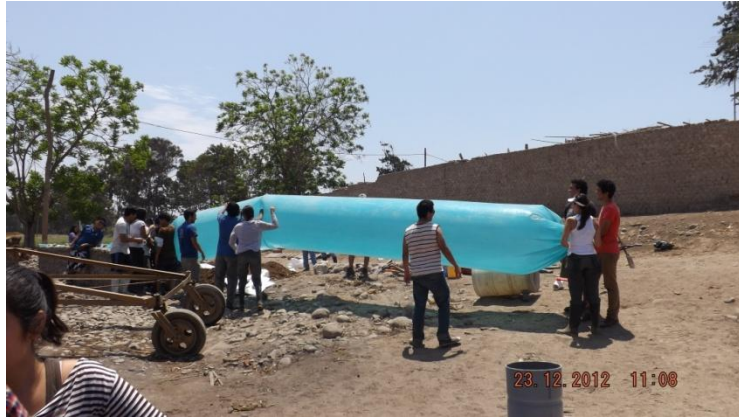
Foto 9. Prueba de hermeticidad en el biodigestor
