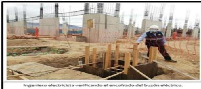
Ingeniero electricista verificando el encofrado del buzón eléctrico.
